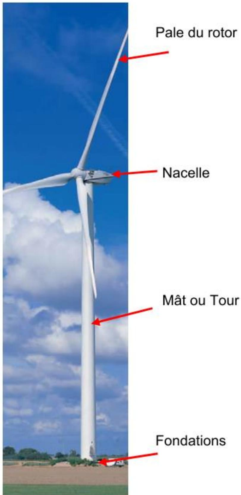
**FIGURE 6 : DESCRIPTION D'UNE EOLIENNE**
