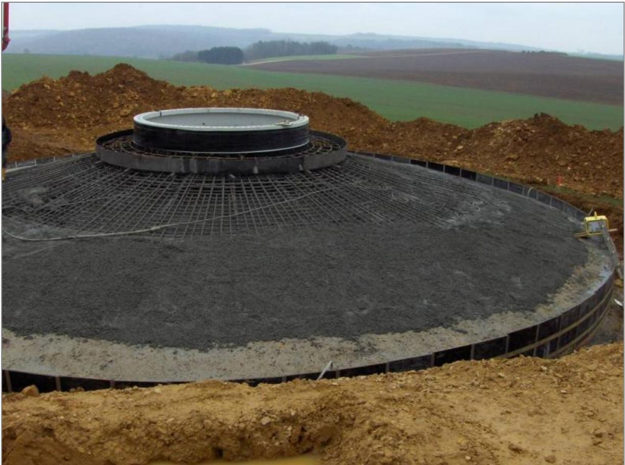
**FIGURE 20 : EXEMPLE DE FERRAILLAGE EN RADIER POUR UNE EOLIENNE**
