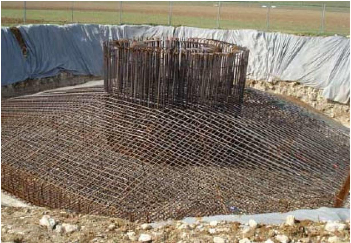
**FIGURE 7 : PHOTO DU FERRAILLAGE D'UNE FONDATION TYPE**
