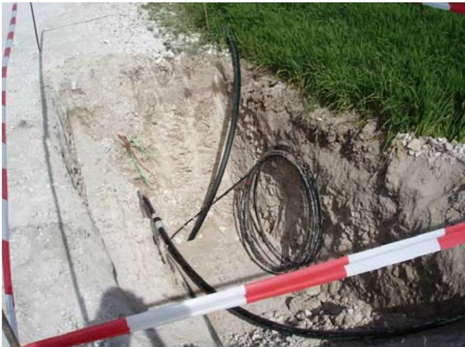
FIGURE 23 : PHOTO D'UNE TRANCHEE POUR L'ENFOUISSEMENT DES CABLES ELECTRIQUES
