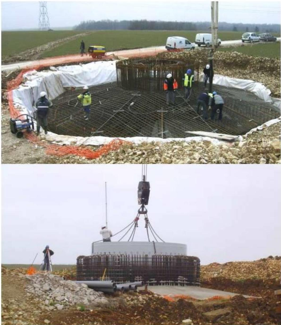
**FIGURE 19 : PHOTO D'UNE FONDATION TYPE AVEC LE SYSTEME DE FIXATION DU MAT**
