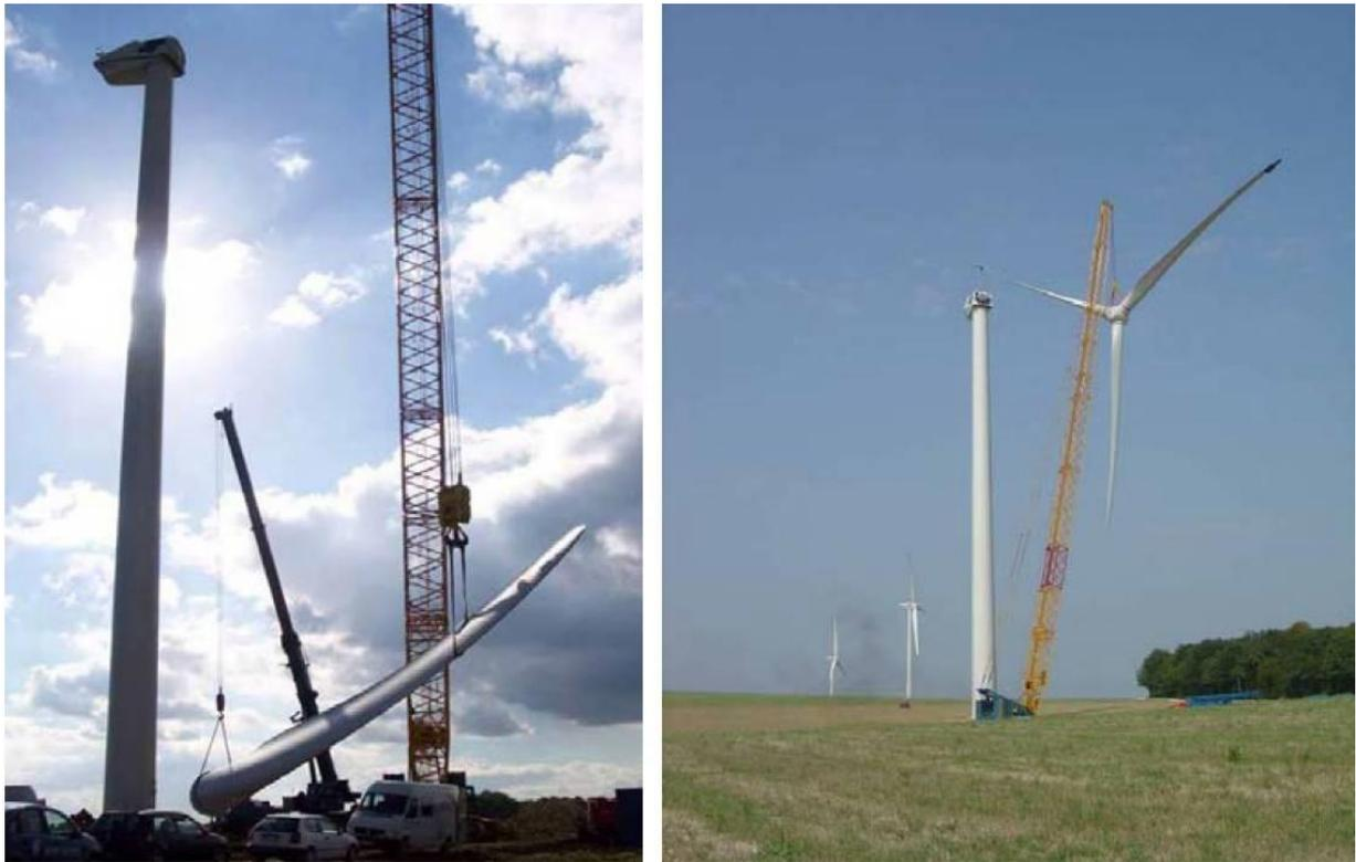
FIGURE 21 : GRUE DE MONTAGE ET ELEVAGE DU ROTOR
